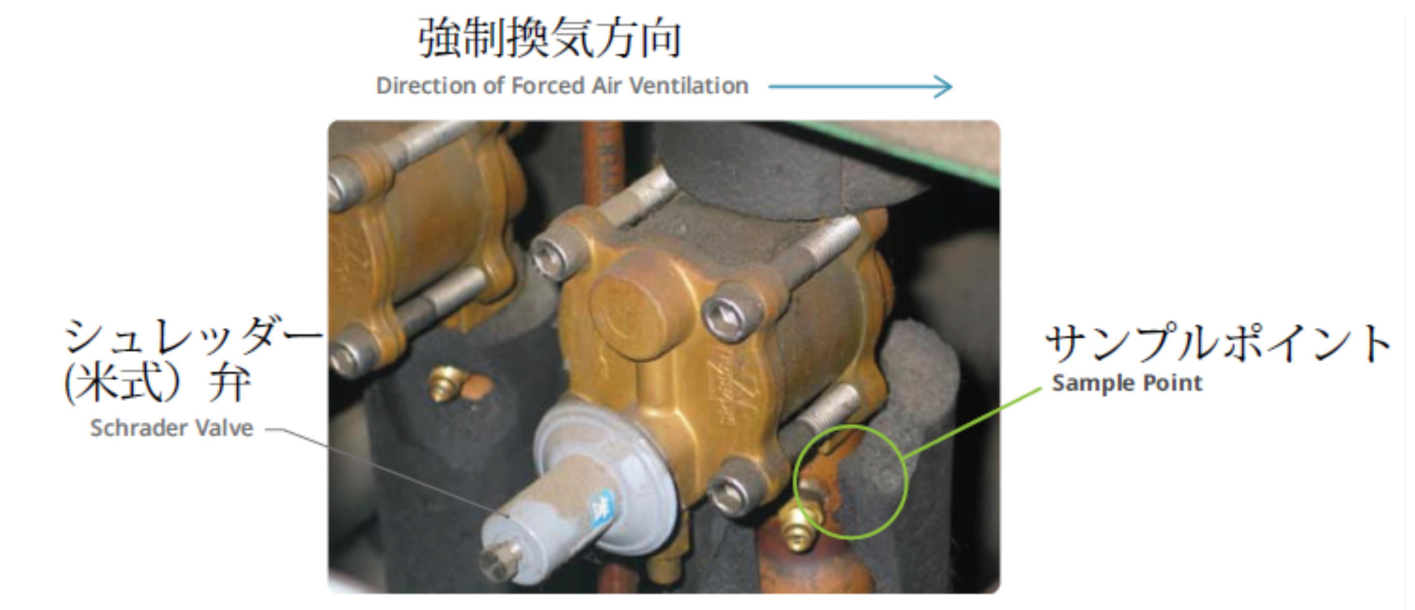
図-8) 既知のリークポイントの近くにサンプルポイントを配置する
